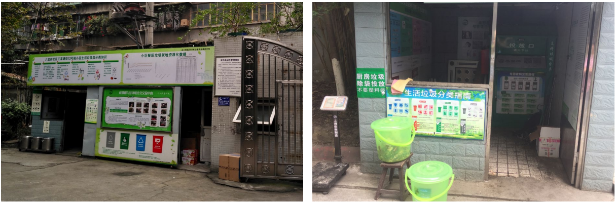
图2 改造后的小区垃圾房（屋外是厨余垃圾投放桶和地秤，屋内设可回收物和有害垃圾投放桶）
