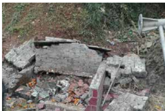
【图】拆除垃圾池
